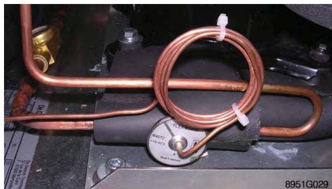
Détendeur thermostatique (ROE+, SOLO, NAPO)
