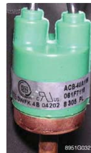
Pressostats HP et BP (Les modèles ROE n'ont que le HP) Ces pressostats sont à contact normal fermé sous la pression de fonctionnement.
