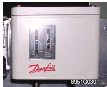
Pressostat fin de dégivrage sur ROE+
