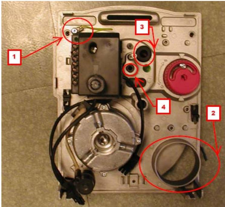
1. Nouvelle fixation de la cosse de mise à la terre (anti-rotation de la cosse)
